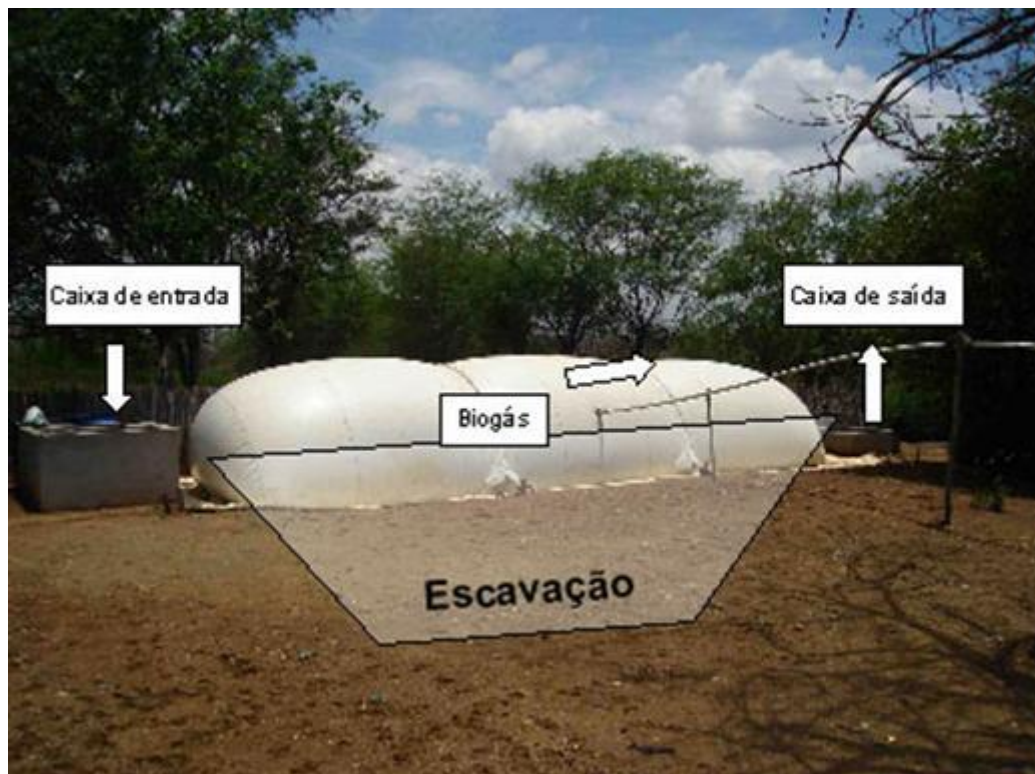
Figura 29: Biodigestor Modelo Canadense
